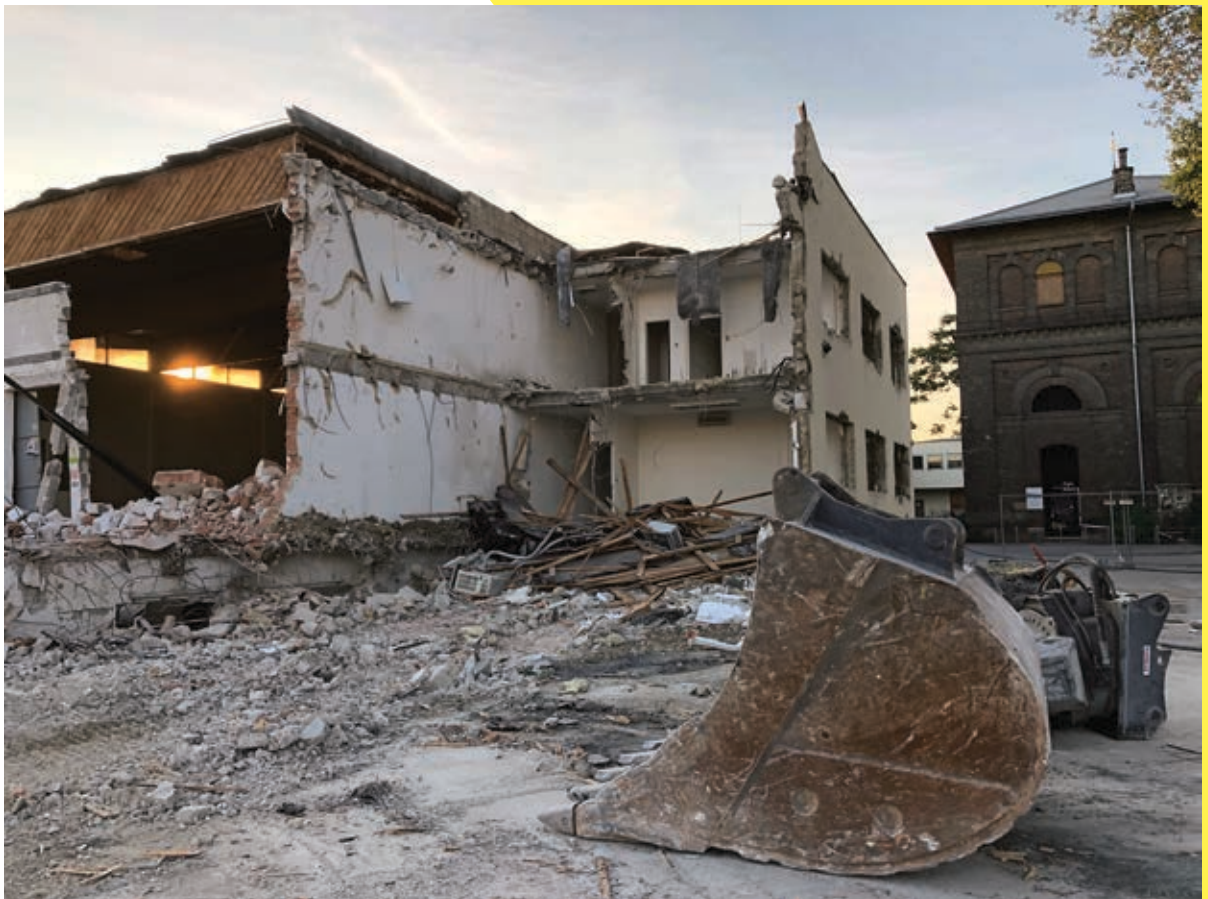
oben Kunst- und Kulturraum Mo.ë in Wien Ottakring, vor Entmietung des Vereins aus den Räumlichkeiten. unten Die Nordbahnhalle nach dem Teilabriss und vor dem Brand.
