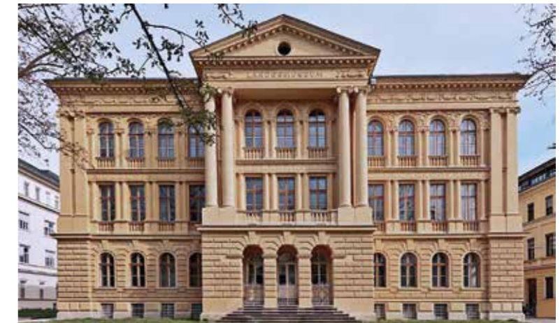
Die Fassade des Rudolfinums bleibt von den Umbauarbeiten weitestgehend unberührt – jedoch wird im Inneren „aufgeräumt“, wie Architekt DI Roland Winkler die Arbeiten zusammenfasst.
