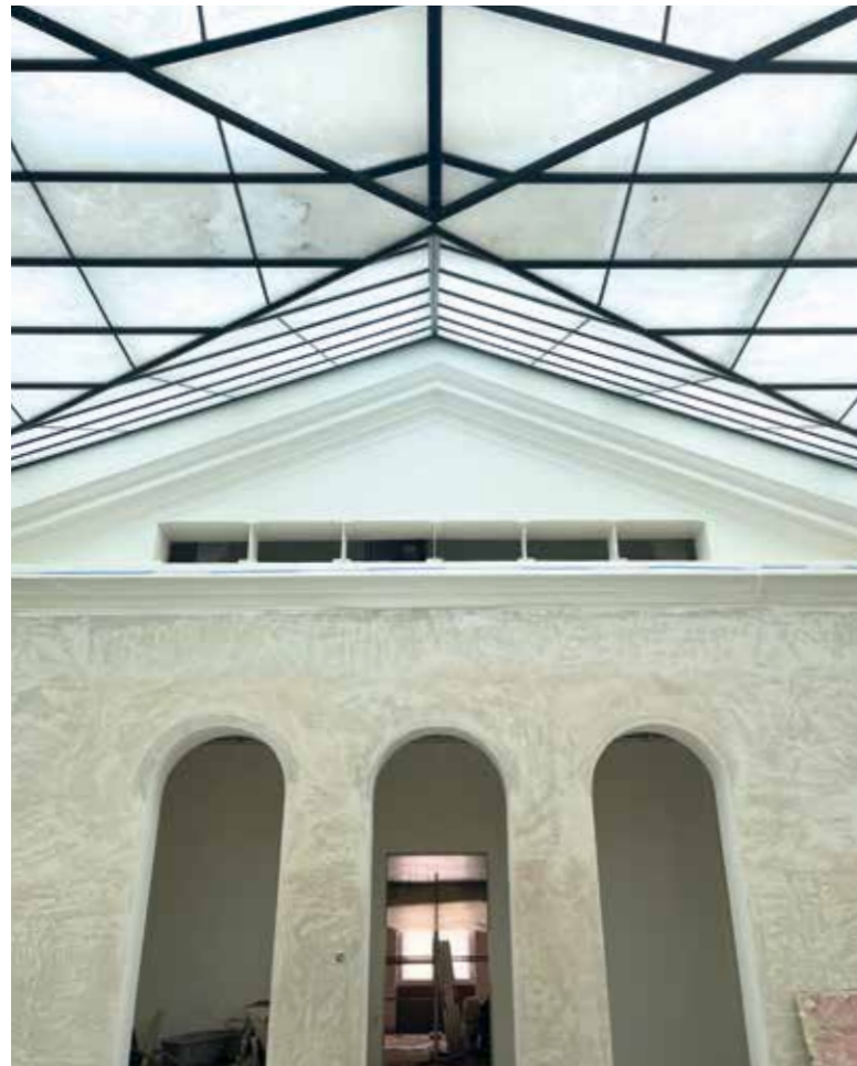
Das Haupthaus des Landesmuseums, hier ein Blick auf die neue Dachkonstruktion. Der Baustart erfolgte im Mai 2020. Foto: © Hornböck
